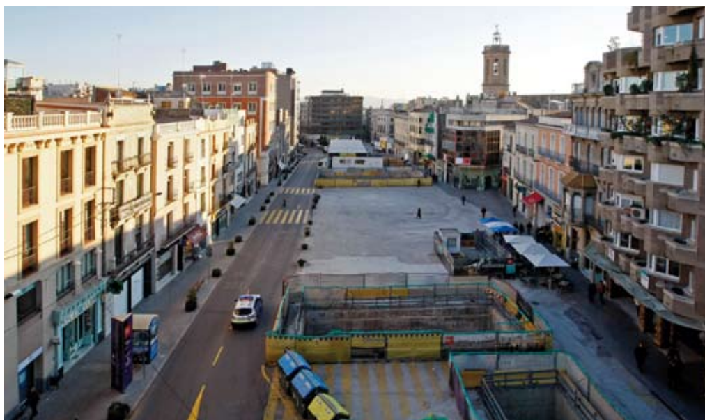
El passeig en el seu estat actual permet el pas de vianants còmodament
