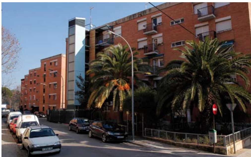
La instal·lació d'ascensors permet millorar l'accessibilitat i la mobilitat de la ciutadania
