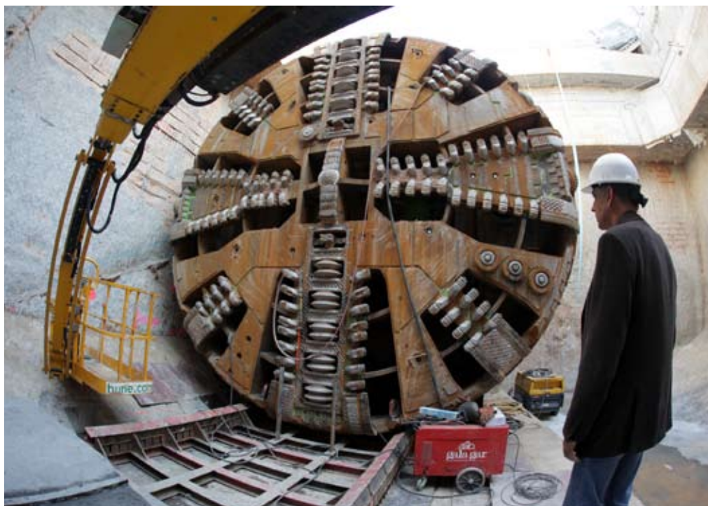
La tuneladora Sabadell ha completat la construcció del primer túnel
