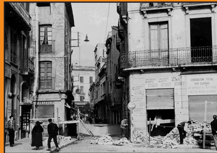
En aquesta fotografia es pot observar el traçat del carrer de Manresa vist des del passeig de la Plaça Major abans que s'iniciessin les obres d'enderroc per tal de convertir-lo en passeig.
