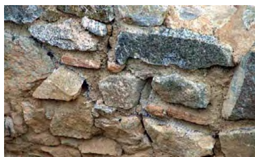
Consolidació de murs al Jaciment de la Cella Vinaria de Teià.
