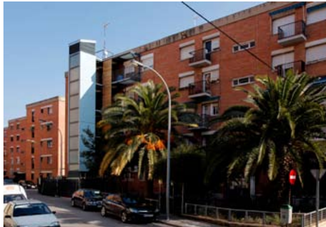
L'Ajuntament ha impulsat la instal·lació de 52 ascensors el 2010
