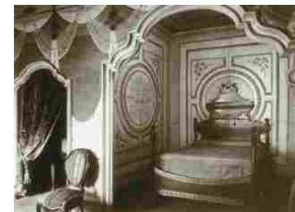
Dormitori de la Casa Duran. Sabadell, s. d. Autor: desconegut / AHS.
