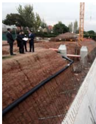
Obres del nou edifici de vestidors i serveis
