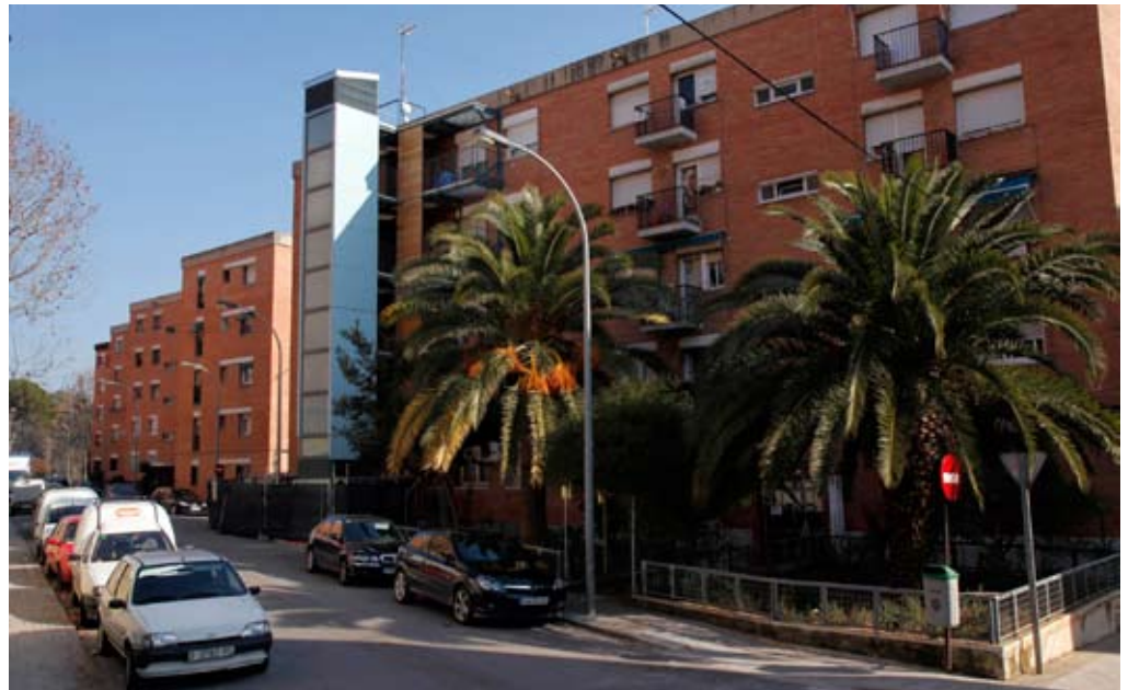
La instal·lació d'ascensors permet millorar l'accessibilitat i la mobilitat de la ciutadania
